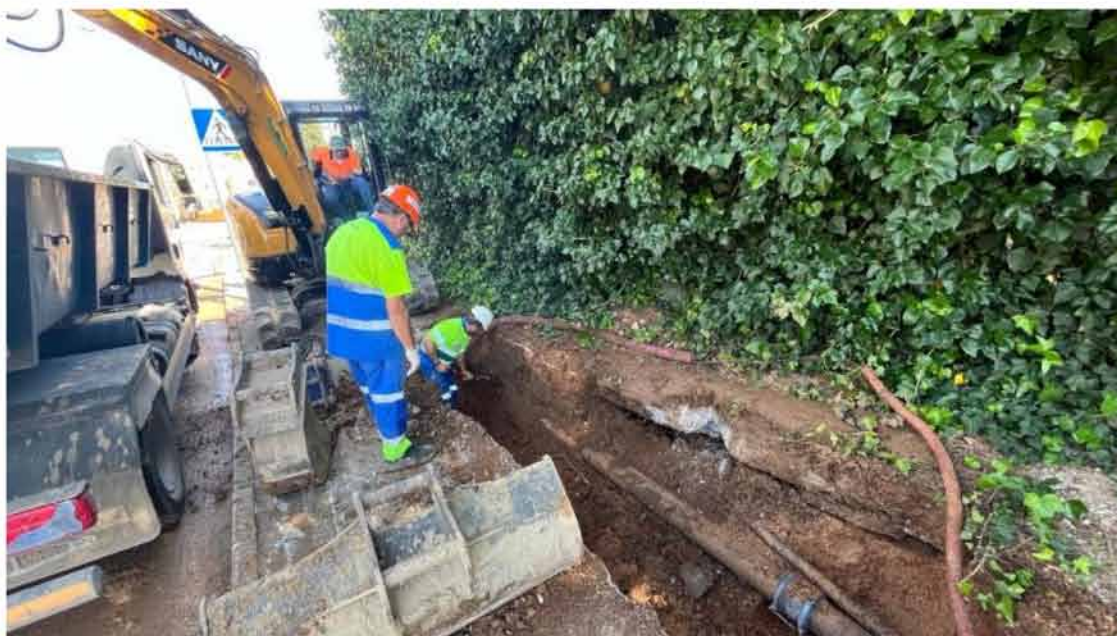
Trabajos en la zona. / FOTO: AAM
