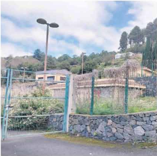
RARA VEZ SE VE A OPERARIOS DENTRO DE UNA PLANTA CERRADA CON CANDADOS. A. P.
