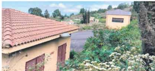
DOS DE LOS MÓDULOS SITUADOS EN LA SEGUNDA ALTURA DEL EQUIPAMIENTO. A. P.
